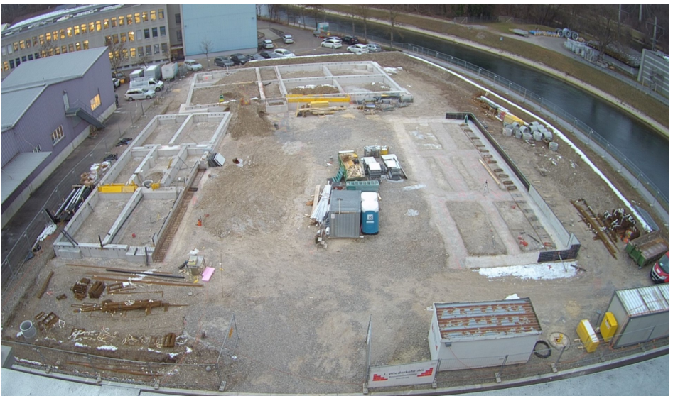
Baustelle Pavillon Stierenmatt im Limmatfeld (Webcam-Bild vom Januar 2021)
