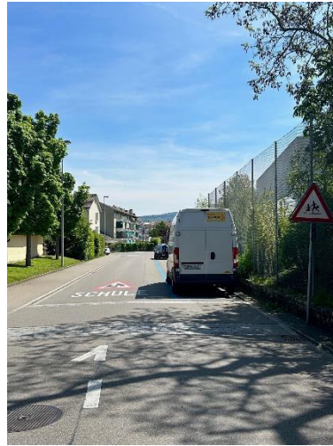
Gefahrensignal 1.23 mit Zusatztafel "Schule" sowie Bodenmarkierung Gefahrensignal "Kinder" und Aufschrift "Schule" und Schwelle Ort: von der Steinmürlistrasse aus gesehen durch die Keltenstrasse
