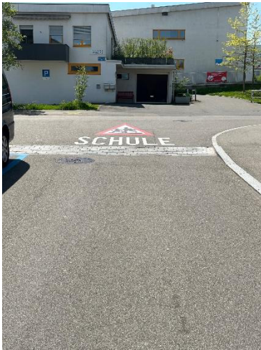
Bodenmarkierung Gefahrensignal "Kinder" und Aufschrift "Schule" sowie Schwelle Ort: Römerstrasse in Richtung Schulhaus
