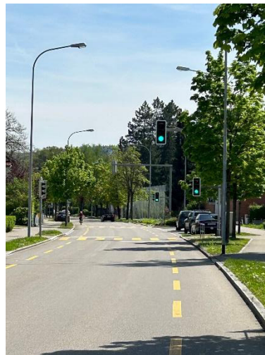
Zwei Fussgängerstreifen, beide mit Lichtsignalanlage Ort: Schöneggstrasse, Höhe Schulhaus Wolfsmatt
