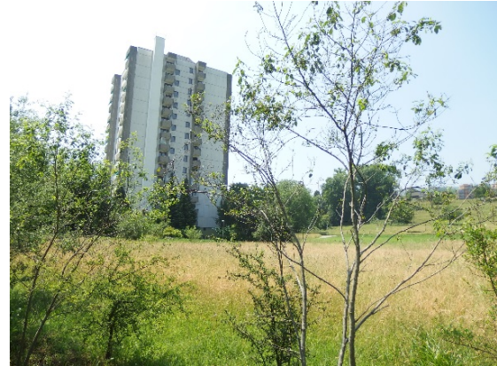
Verdichtung durch bauliche Ergänzung würde die Qualität der heutigen Siedlungen einschränken (Bild: Van de Wetering)
