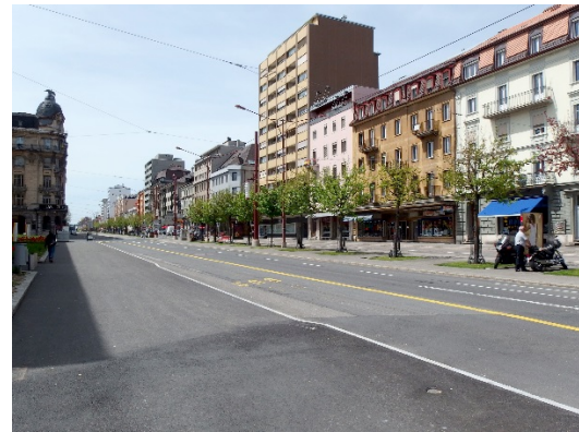
Referenzbeispiel Avenue Léopold-Robert, La Chaux-de-Fonds: die Hochhäuser sind wie alle anderen Häuser an der Baulinie eingefügt. Es gibt keine Vor- oder Rücksprünge, der Stadtraum bleibt als Ganzes lesbar (Foto: Van de Wetering)
